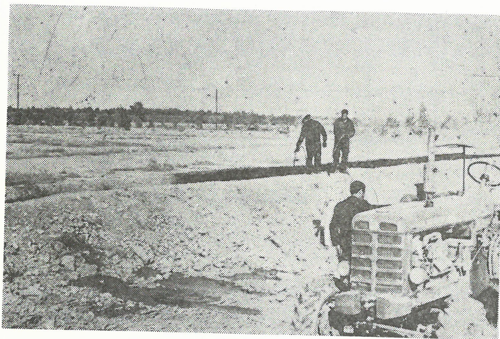
پخش امولسیون قیر در کانالهای آبیاری خاکی (در محل دانشکده پزشکی دانشگاه جندی شاپور)
